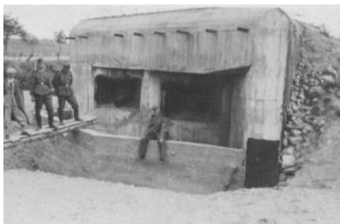
Rów diamentowy przed ambrazurami schronu
