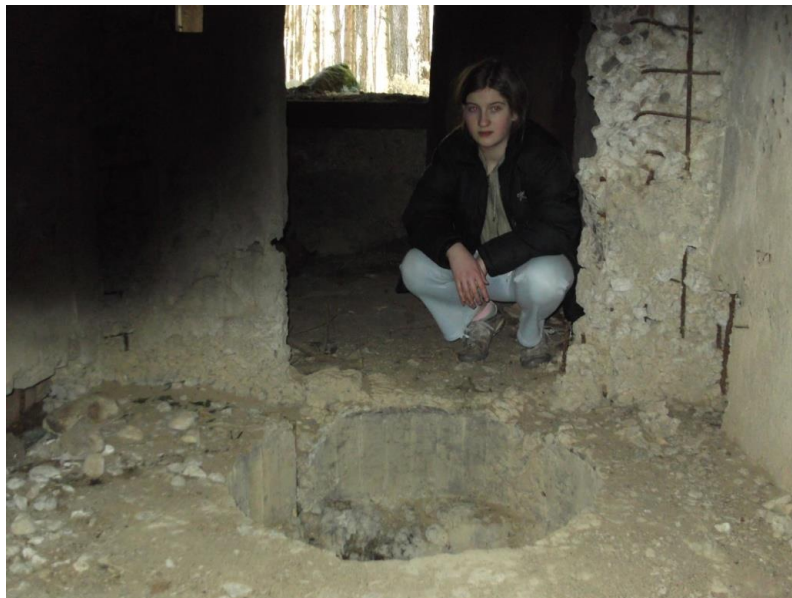
Zejsćcie na niższą kondygnację w schronie wielopoziomowym
