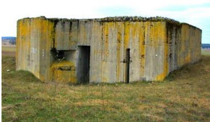
Od lewej: strzelnica rkm-u do obrony zapola, otwór wejściowy i szczelina detonacyjna w schronie w Bohaterach
