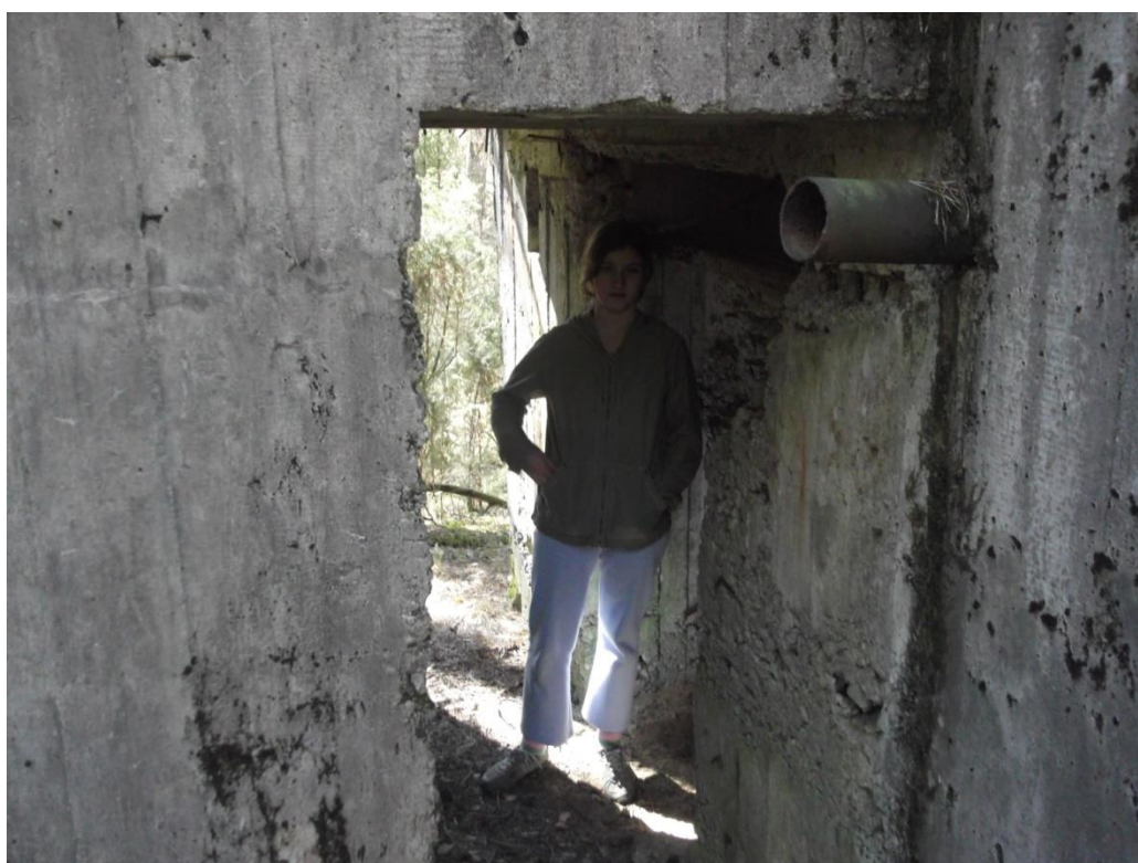
Ustęp, toaleta sucha tzw. turecka na najniższej kondygnacji schronu
