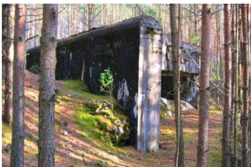
Od lewej: strzelnica rkm-u do obrony zapola, otwór wejściowy i szczelina detonacyjna w schronie w Bohaterach
