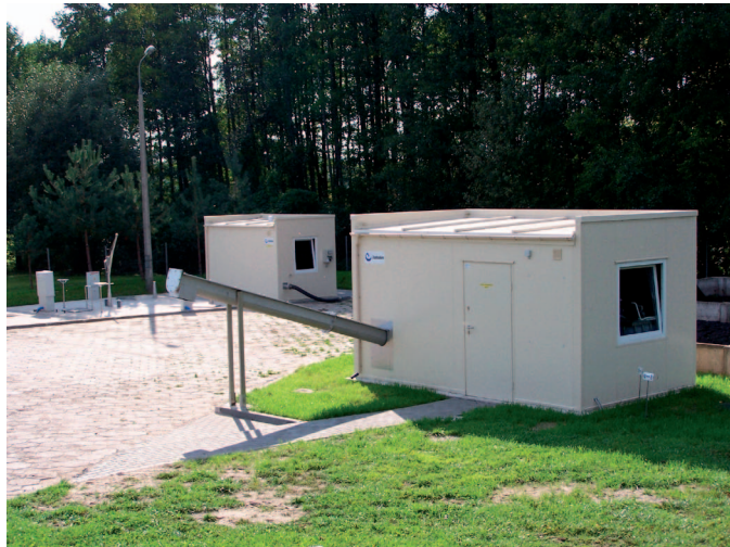
Oczyszczalnia ścieków w Lipsku
