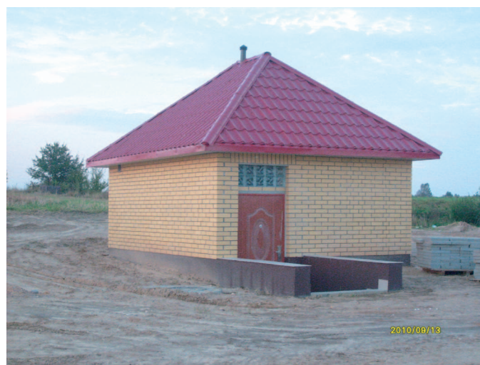
Sieciowa pompownia wody w Rakowiczach
